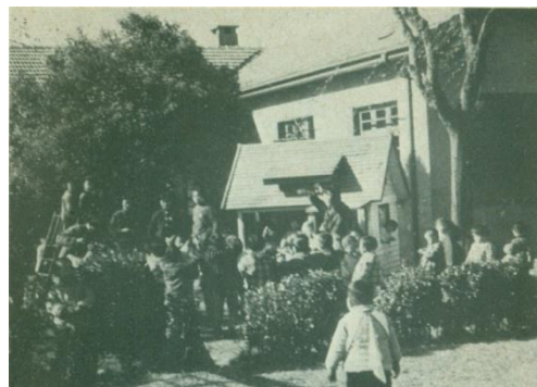
La guardería de la ciudad obrera, construida por los habitantes del barrio, a la derecha una casita de madera para los juegos de los pequeños
